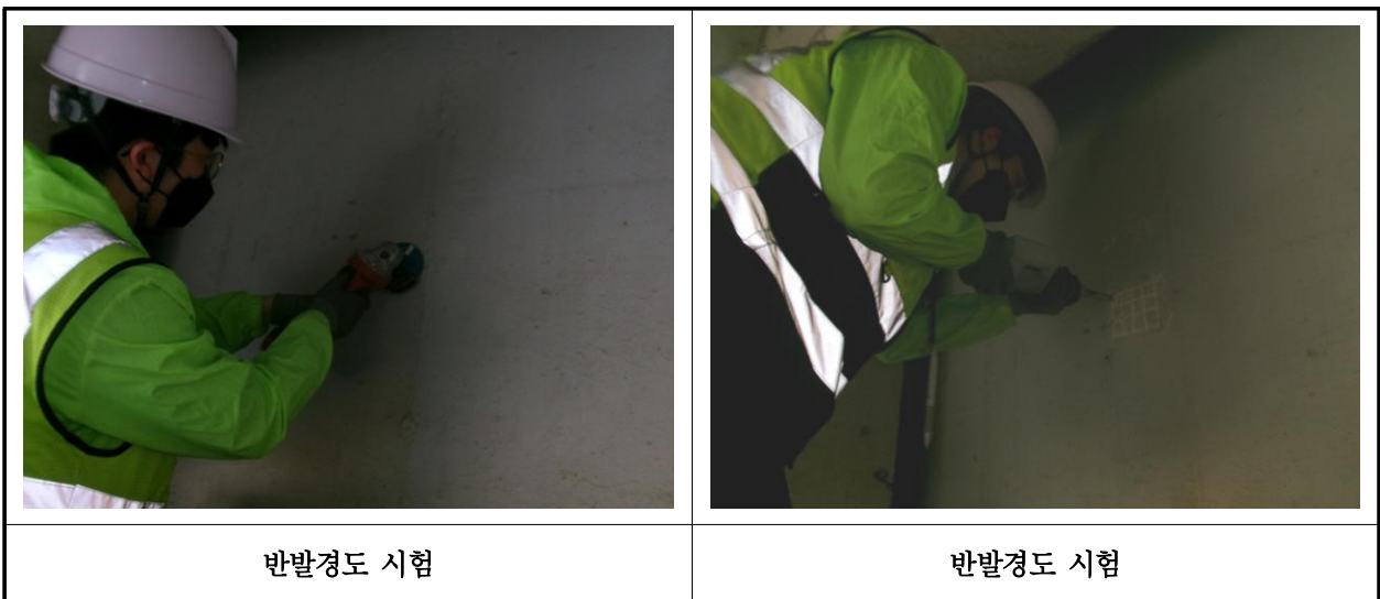
【사진 1.4.1】 반발경도시험 현장사진
