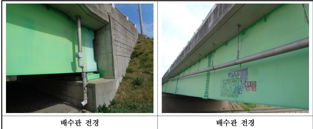
【사진 1.3.19】 배수시설 전경
