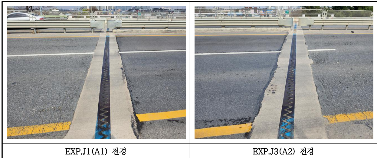
【사진 1.3.14】 신축이음장치 전경
