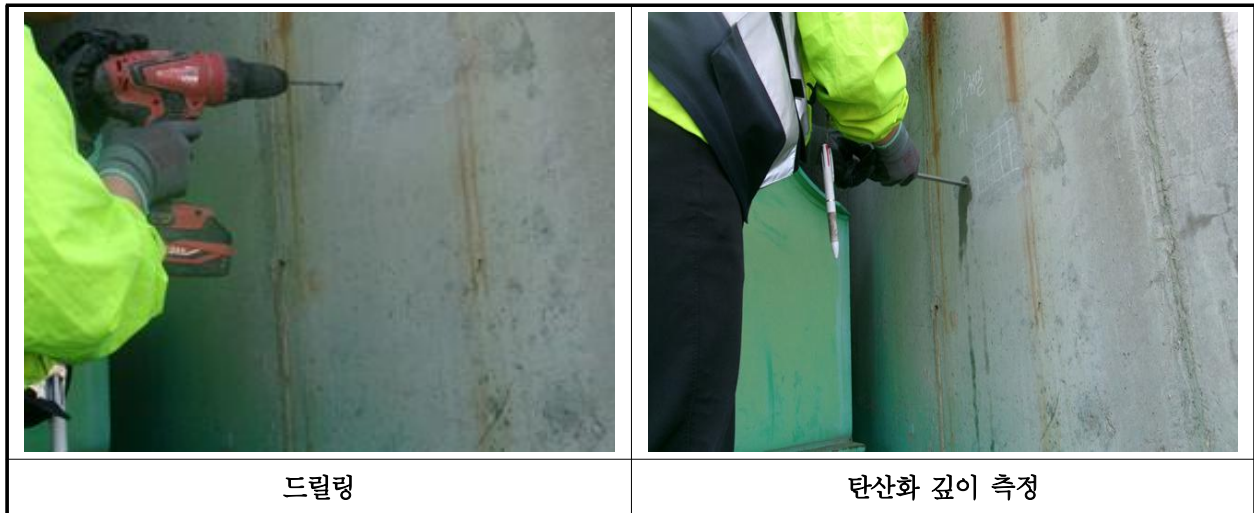
【사진 1.4.2】 탄산화 깊이 측정 현장사진
